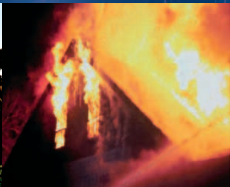
Brand eines Wohnhauses durch einen direkten Blitzeinschlag
